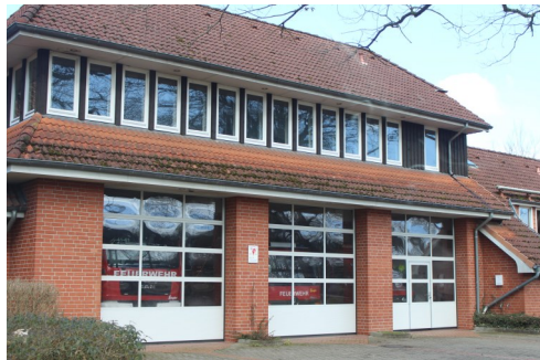
Unser Feuerwehrgerätehaus mit den neuen Toren
